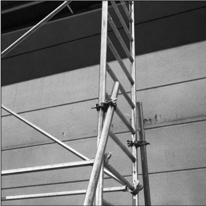
23. Die Befestigung der Alu-Gerüstrohre an dem Leiterrahmen (1) erfolgt mittels Drehkupplung (14). Die Flügelmutter mit der Hand fest anziehen.
