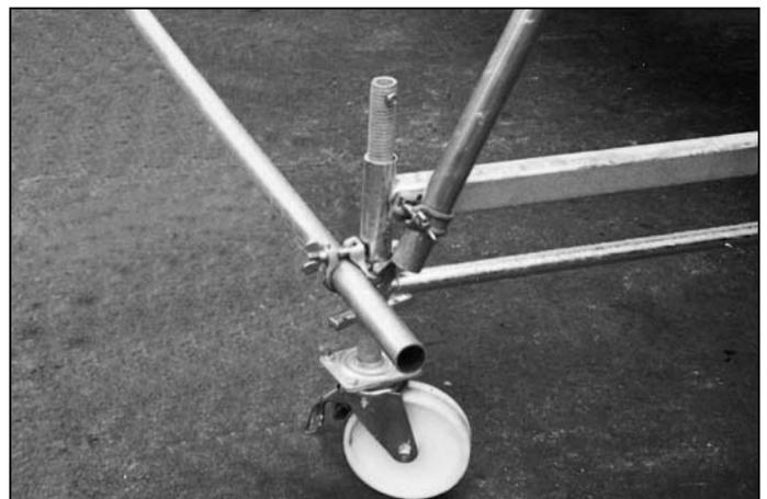
22. Alu-Gerüströhr 2,00 m/ 3,00 m (6) an die außenliegenden Kupplungen an den Fahrballen (9) einführen und nach oben zu den Leiterrahmen abstreben.
